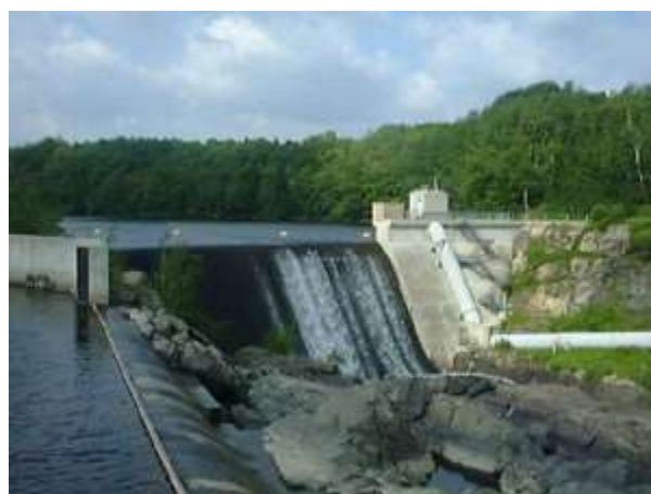
Figure 39: Barrage de St-Raphaël
