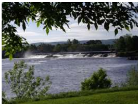
Figure 37: Barrage de Montmagny
